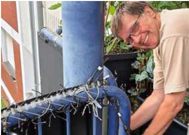
Montage 1: Marco Latinga befestigte seine Solarmodule mit Edelstahlkabelbindern am Geländer.
