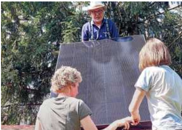
Montage 2: Beim Aufbau auf einem Garagendach ist gemeinsames Anpacken unerlässlich.
