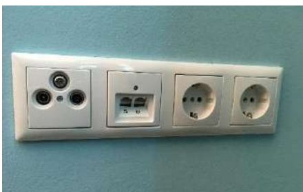
Abbildung 70: Mögliche Konfiguration von Wandauslässen (Koax, Daten und Strom) (Quelle: DT)
